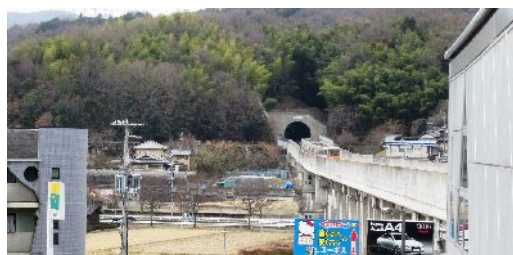
学研北生駒駅付近
